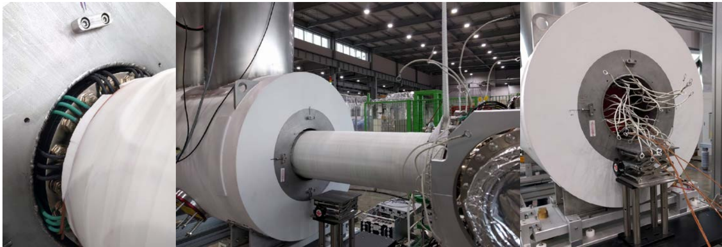
④ SC magnet bore 내 DT chamber 설치 작업
